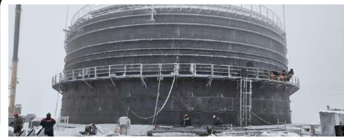
Резервуар Вертикальный Стальной 10 000 м 3 г. Качканар
